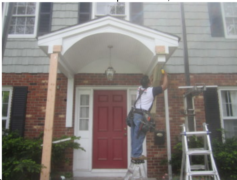
Fascia Trimming NJ.
