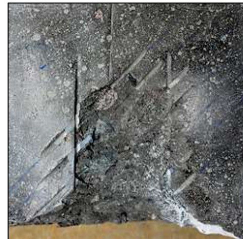
Dengan perawatan Kehancuran pada beton
