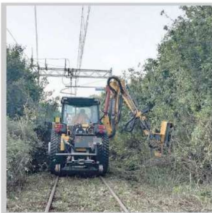
Il disboscamento della Ponte San Giovanni-Terni
