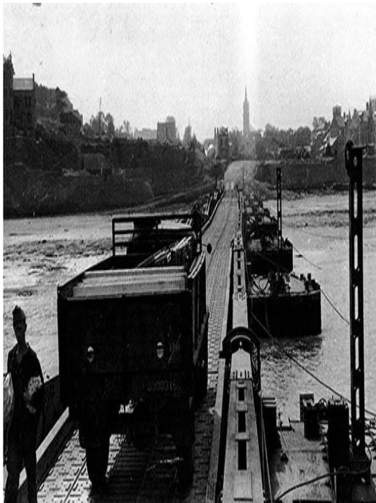
O porto artificial de Mulberry, construído para o desembarque na Normandia, em 6 de junho de 1944, aqui visto um mês depois, após a cabeça de ponte ter sido estabilizada.
