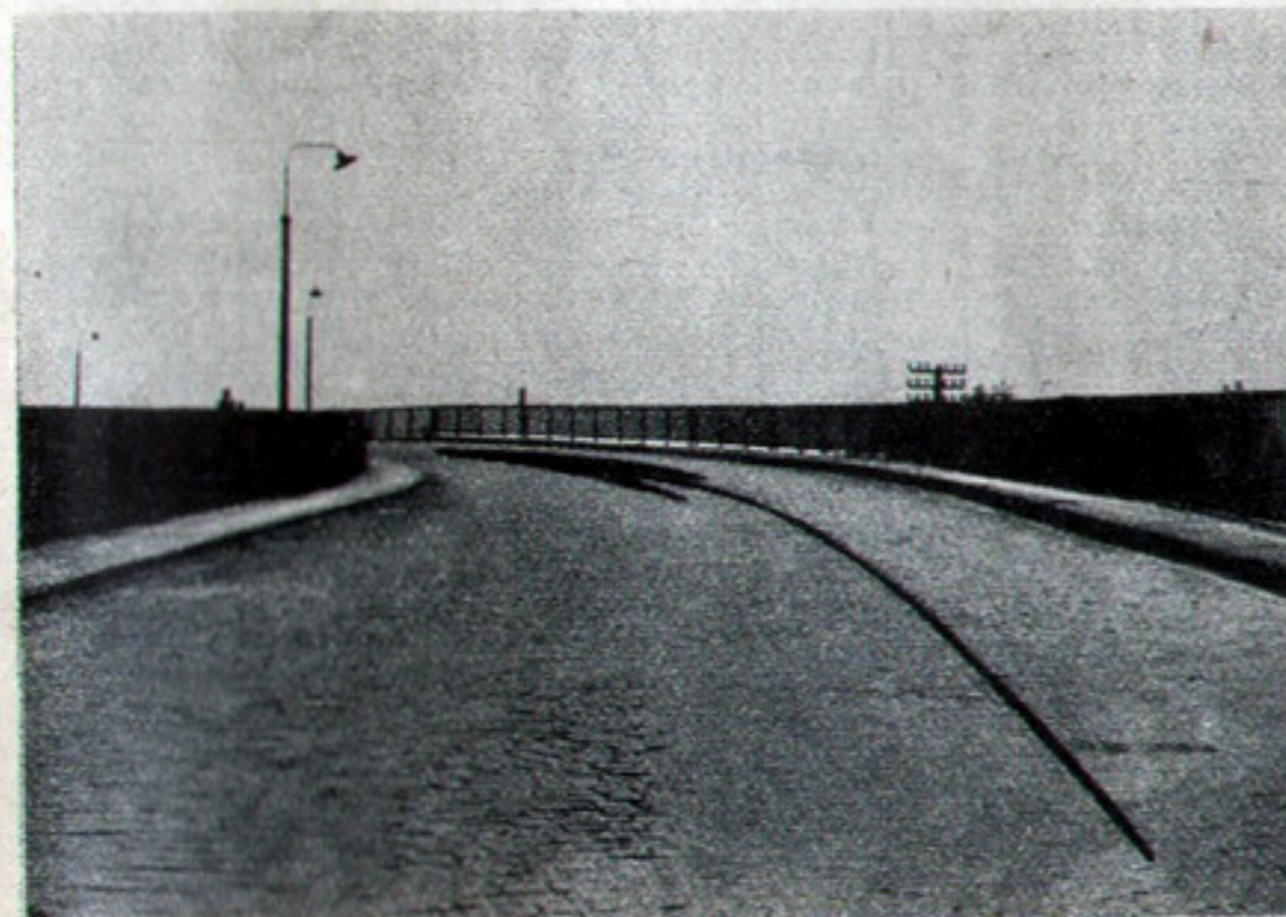
A fékezett keréktől eredő oldalcsúszási nyom, amely az autóbusz erőteljes visszakanyarodásától keletkezett
