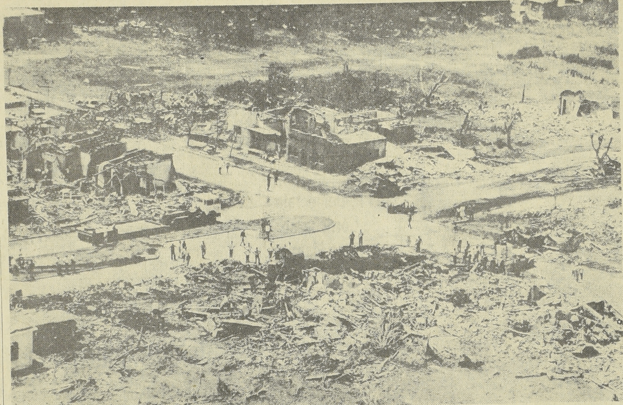
VISTA AEREA DE UNO DE LOS SECTORES MAS AFECTADOS POR EL TORNADO, DONDE PUEDE APRECIARSE QUE LAS DISTINTAS CONSTRUCCIONES RESULTARON REALMENTE ARRASADAS
