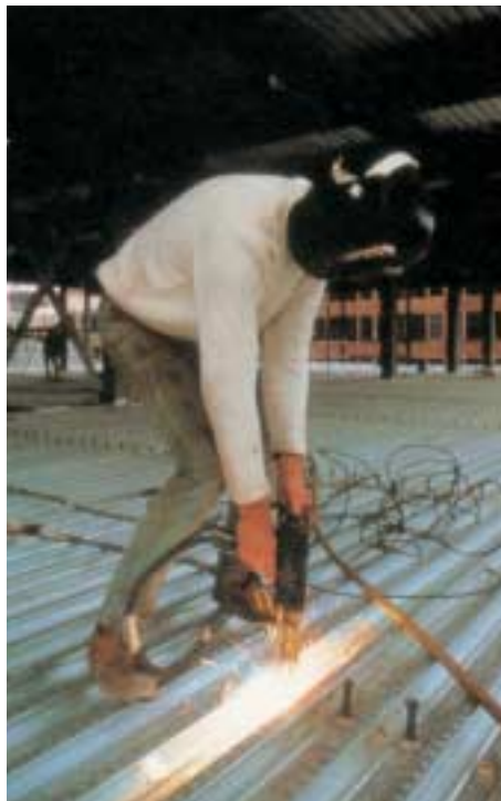
Soudage de goujons sur chantier à travers les bacs en acier
