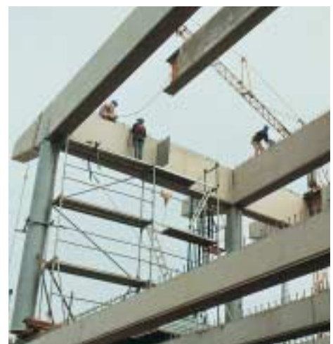
Siège des P&T, Saarbrücken (D)
