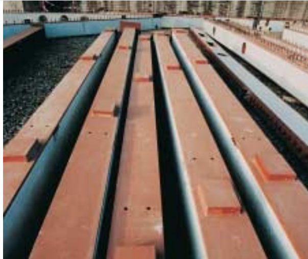
Poteau avec tasseaux avant montage
