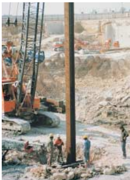
Poteau préfondé en cours de montage
