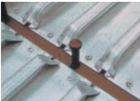
Bacs en acier avec fermeture des ondes par écrasement
