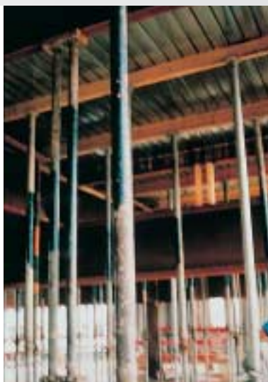
Etaielement provisoire des tôles de grande portée lors de la prise du béton
