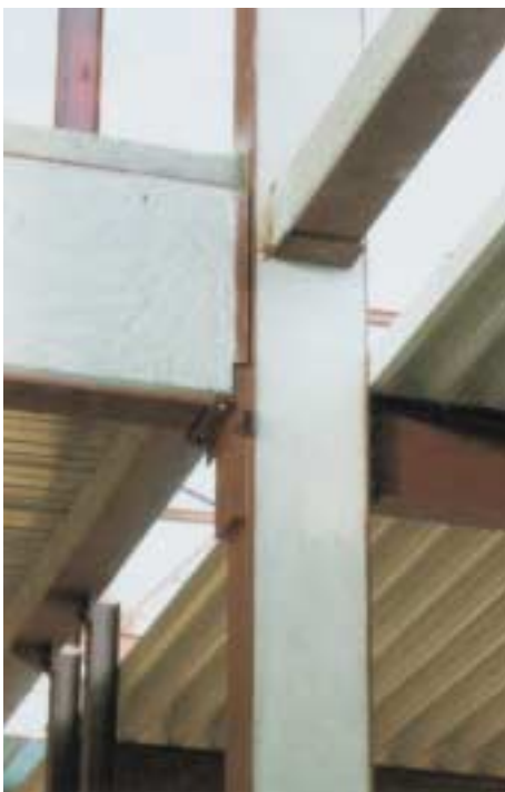
Assemblage sur tasseaux
