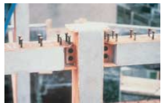
Assemblage par gousset d'âme
