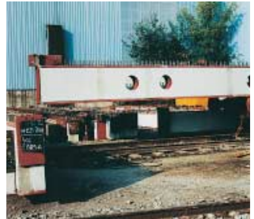
Poutre prébétonnée avec bec d'appui supérieur avant montage
