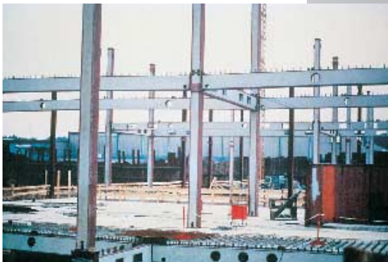
Charpente en construction mixte acier-béton
