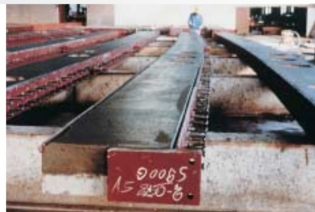
Bétonnage au sol de poutres mixtes
