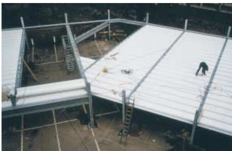
Coffrage à l'aide de bacs autoportants de grande portée
