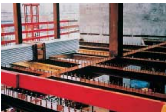
Plancher en cours de montage, Espace Léopold, Bruxelles (B)
