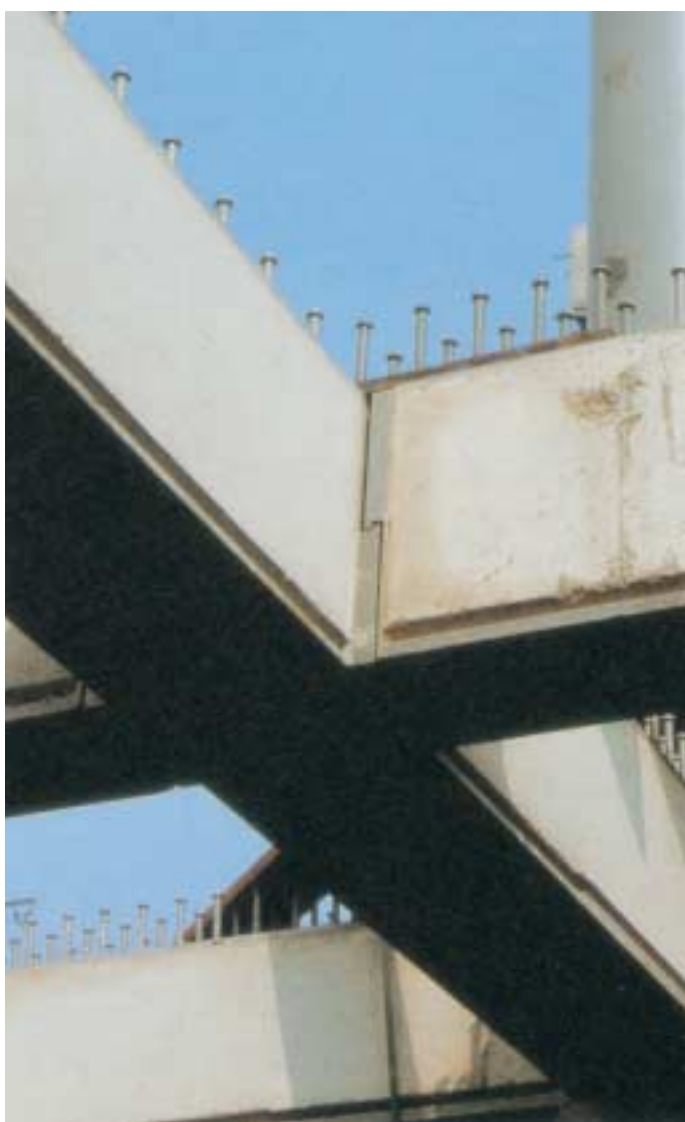
Assemblage poutre dans poutre par tasseaux
