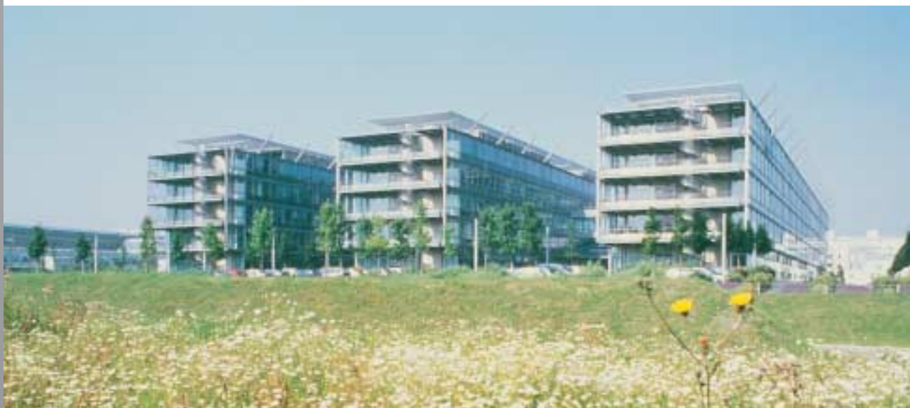
Ecole Nationale des Ponts et Chaussées, Marne-la-Vallée (F)
