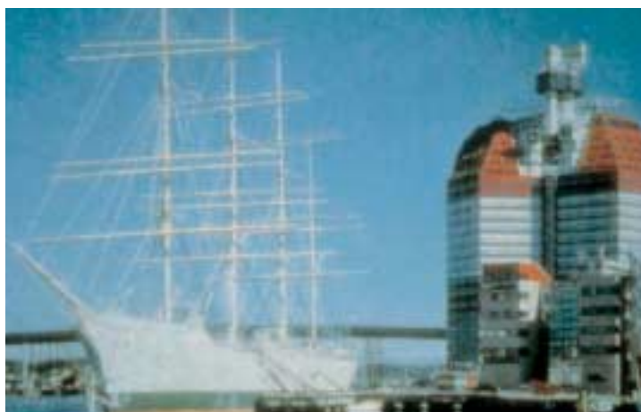
Siège de l'entreprise de construction SKANSKA, Göteborg (S)
