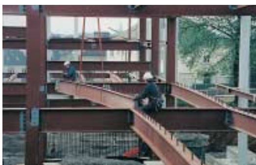
Contreflèche des poutres: Parking du Stade, Luxembourg (L)
