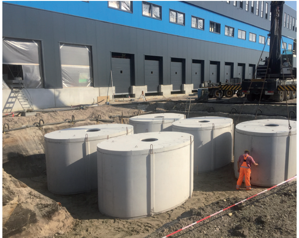
Varitank regenwaterputten van beton worden geplaatst.
