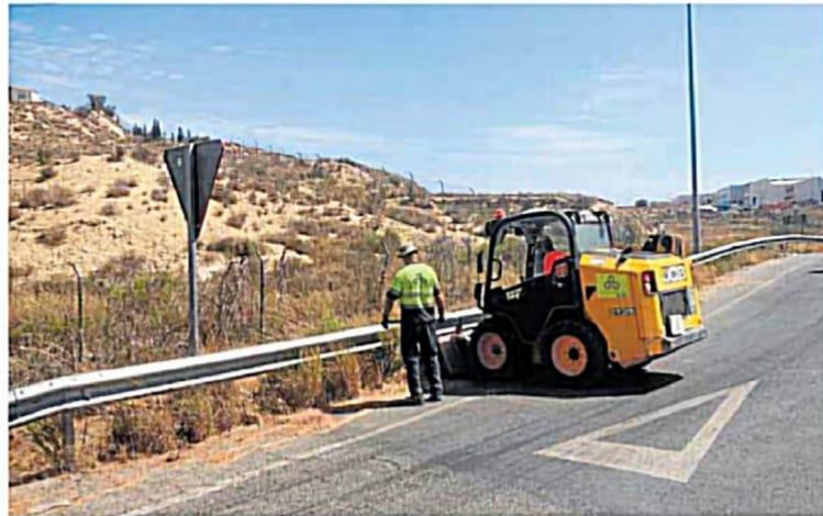
Tareas de limpieza en una cuneta de una carretera del municipio, esta semana. AYTO
