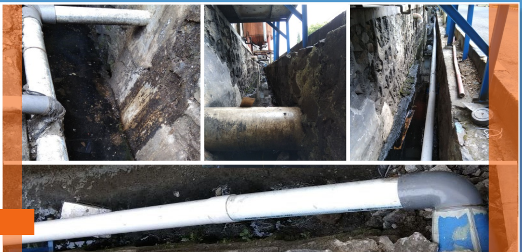
03 Dokumentasi Projek Instalasi Pembuangan Air Domestik Kantin, Mesjid Dan Toilet
