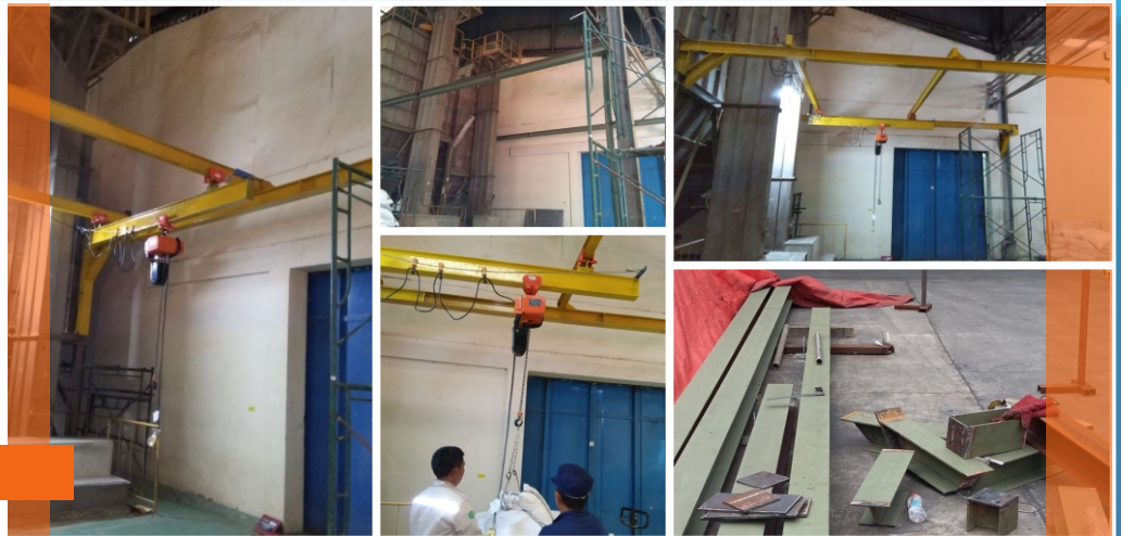
02 Dokumentasi Projek Pembuatan Rel Chain Hoist Silo Gandum.
