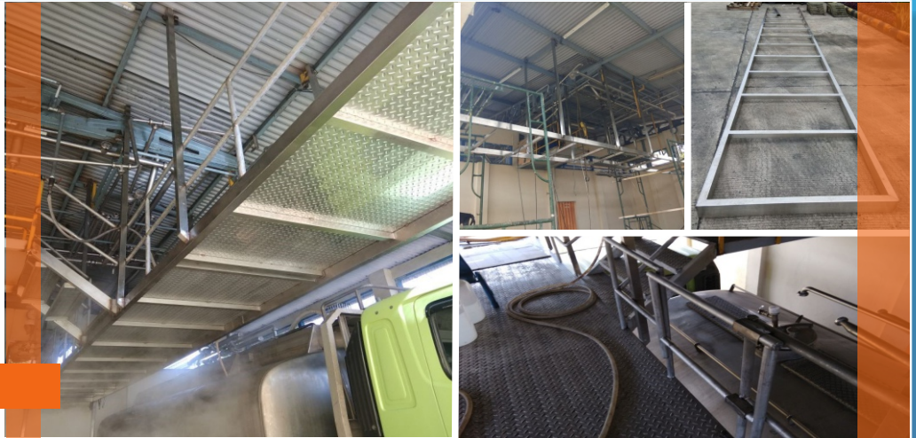
05 Dokumentasi Proyek Jasa Pasang Panggung Pengisian Tangki Kecap
