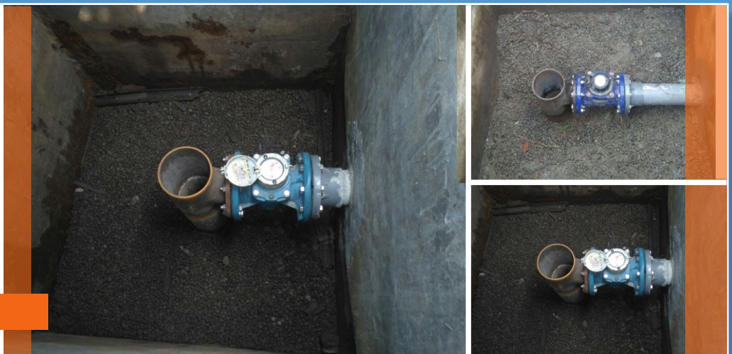
06 Dokumentasi Proyek Pemasangan Flow Meter di Bak Imbuhan No.1 dan No.4.
