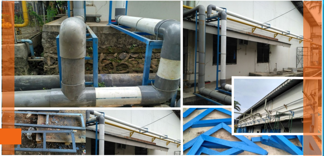
01 Dokumentasi Instalasi Pipa 8 Inch Sumur Resapan.
