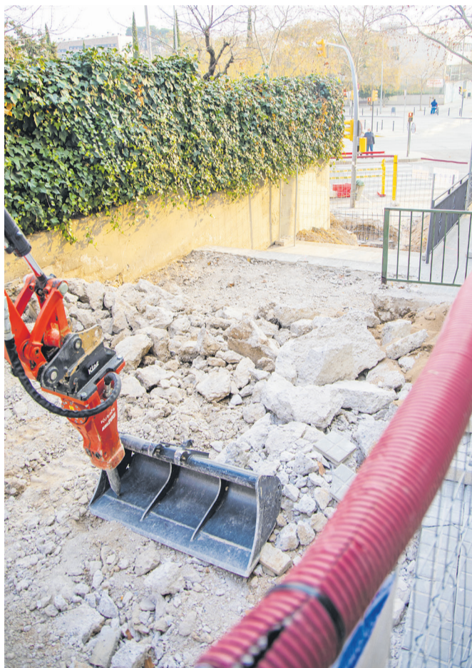
Obres de construcció de rampes al carrer de Palestina, ahir dilluns / VÍCTOR CASTILLO
