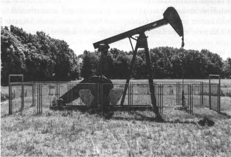
Abb. 115: Historisch Erdölförderanlage bei Heide
