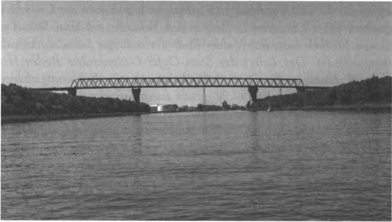
Abb. 100: Die „Hochbrücke Brunsbüttel“ ist die längste Brücke über dem ehemaligen „Kaiser-Wilhelm-Kanal“
