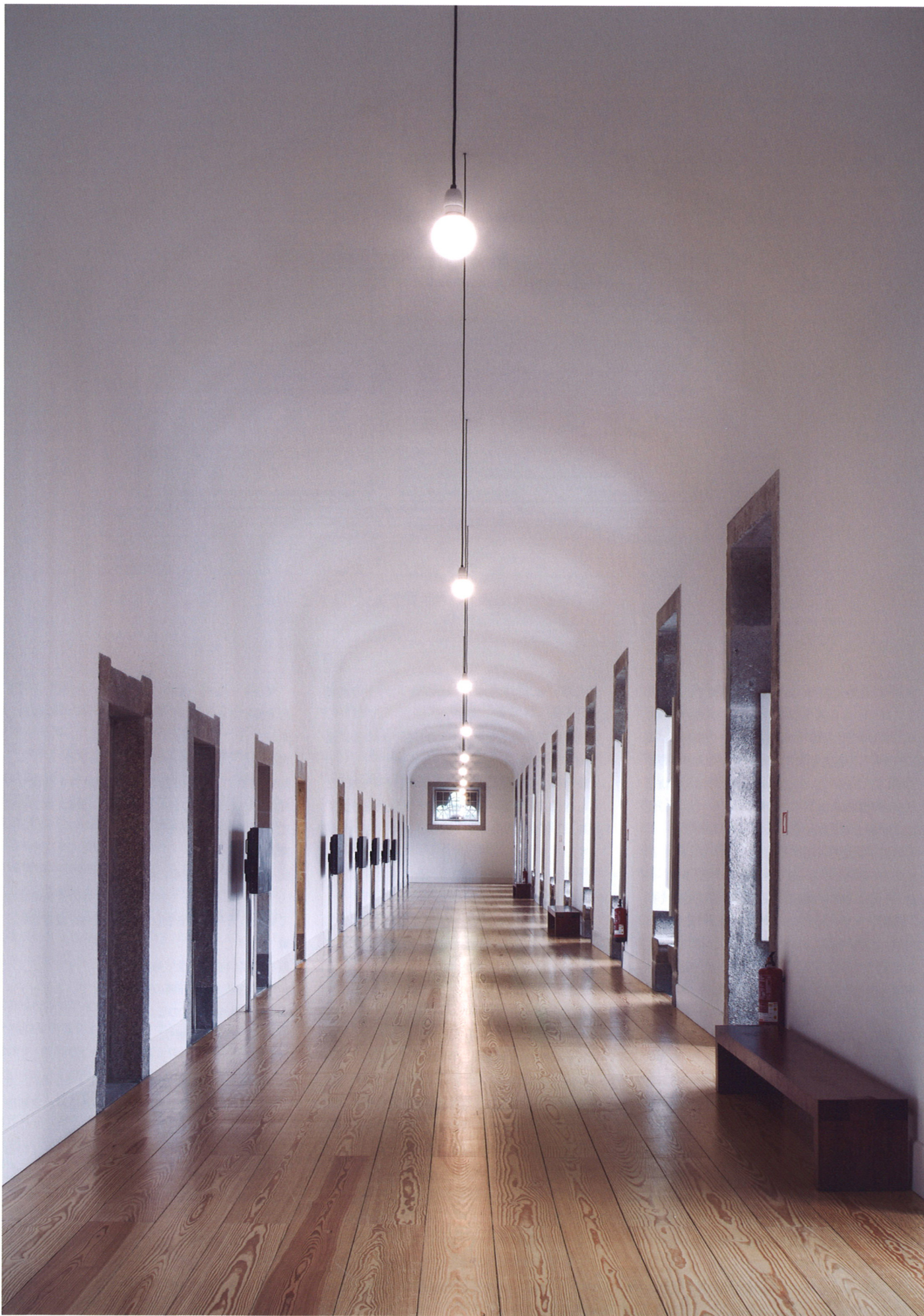
Hallway with vaulted ceiling: view toward vestibule ヴォールト天井の廊下：エントランス・ホール方向を見る
