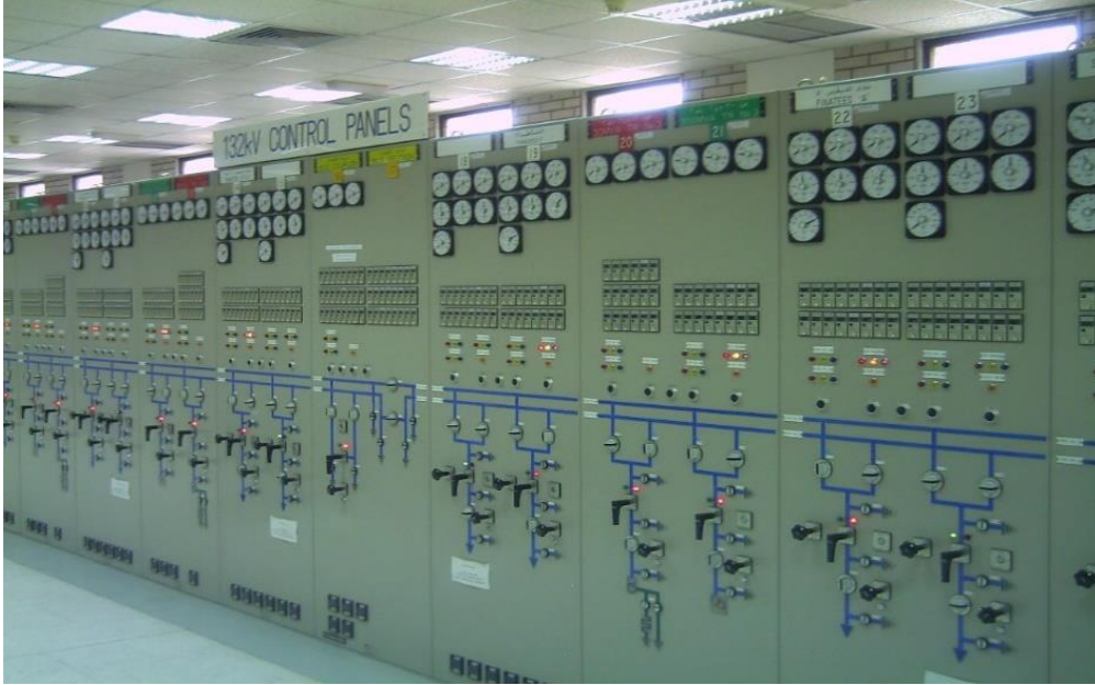
شكل 16-3 : غرفة التحكم في المحطات التقليدية
