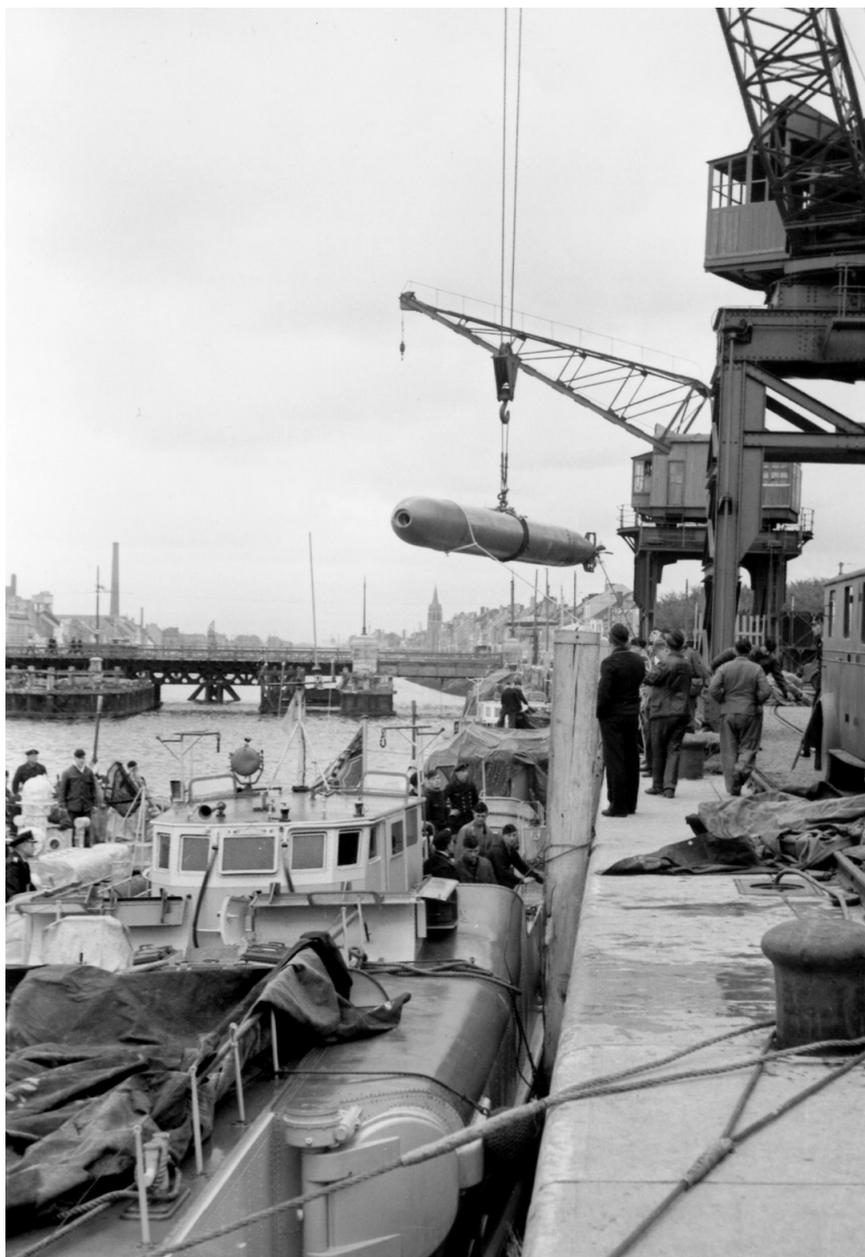
▲ et ▼ Dans le port d'Ostende (Belgique) en septembre 1940, un *Typ S-30* de la 2. *S-Flottille* s'appête à embarquer une torpille *G7a*. Le nez de cette dernière n'a pas encore reçu son système de « mise de feu » (détonateur). Même à l'aide d'un engin de levage, il faut plusieurs hommes pour recharger un tube. En mer, de nuit et durant un combat, une telle opération est encore plus difficile.
