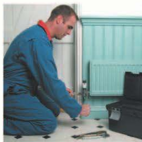
o canalizador plumber
