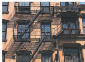
a saída de emergência fire escape
