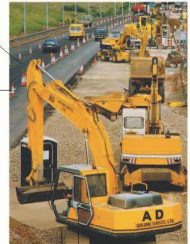
a repavimentação resurfacing
