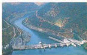
a barragem dam
