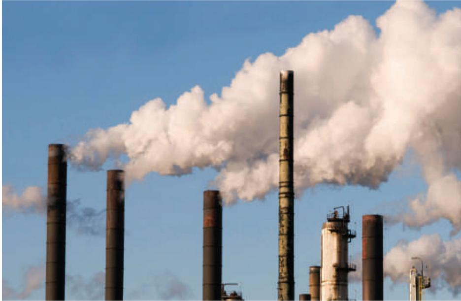
■ الشكل 14-2 الرماد المتصاعد من المداخن نتيجة ثانوية لاحتراق الفحم. ويمكن استعمال مرشحات الترسيب الكهروسكوني لتقليل هذا الرماد.
