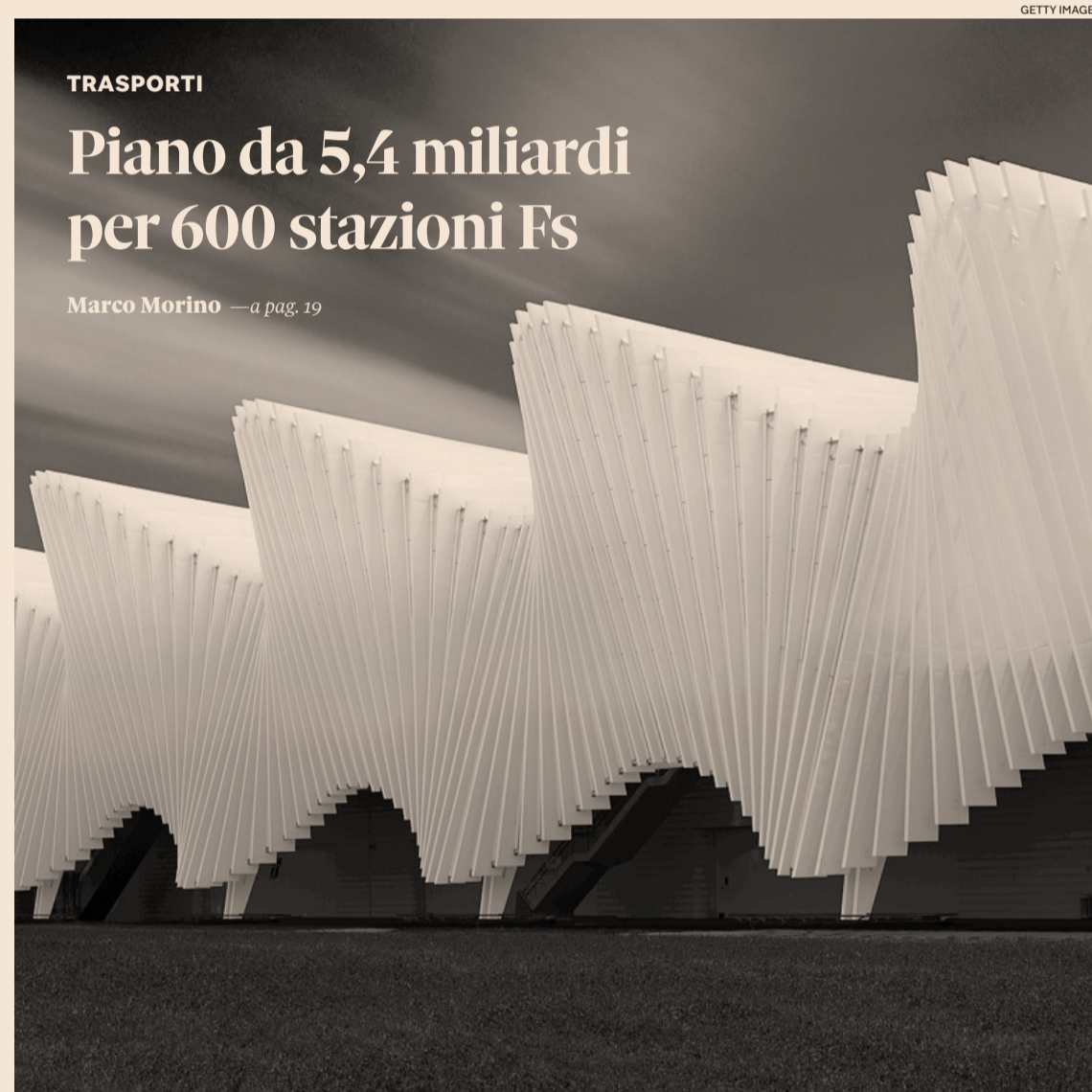
Scali ferroviari. La stazione di Reggio Emilia progettata dall'architetto Santiago Calatrava
