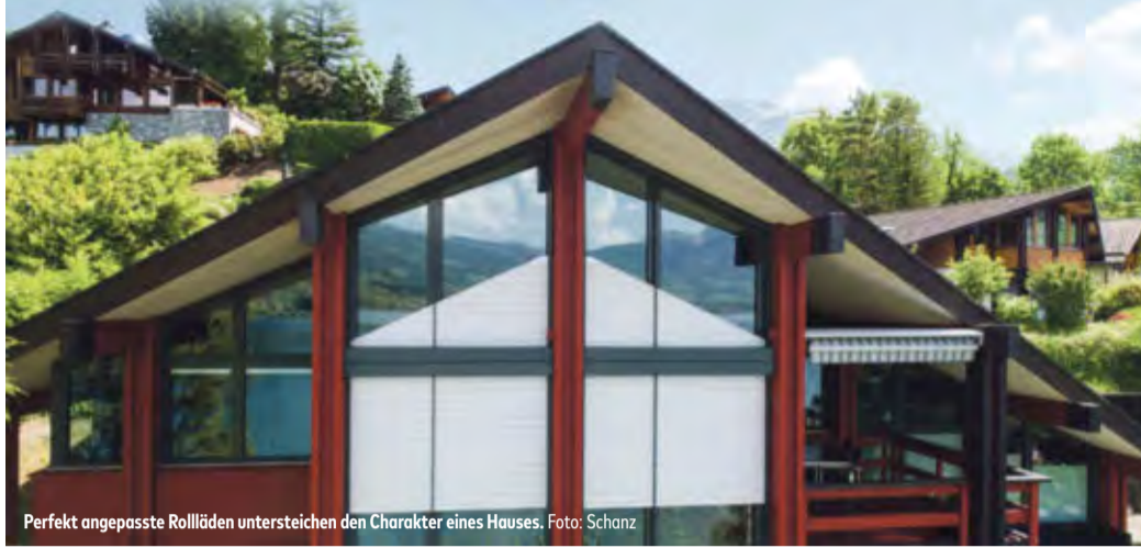
Perfekt angepasste Rollläden unterstreichen den Charakter eines Hauses. Foto: Schanz
