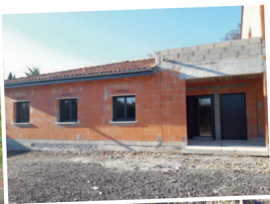
Local de la MAM en cours de construction
