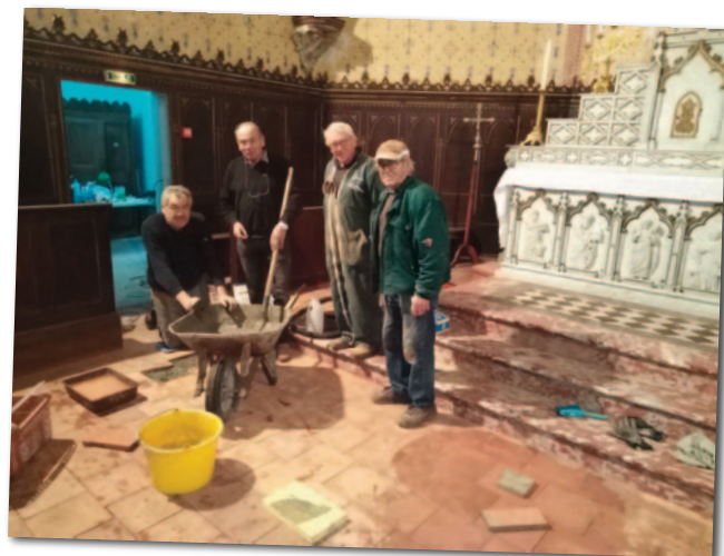
Eglise : travaux à l'intérieur et zinguerie
