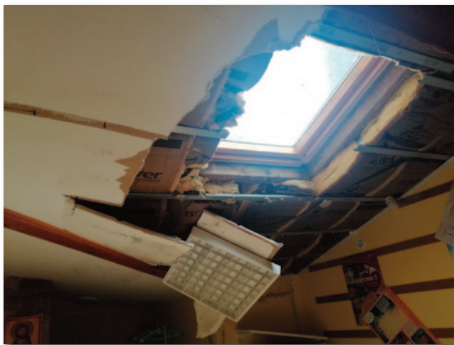
Réparation de la salle de catéchisme
