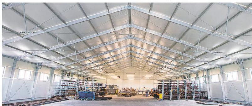
► FUNKCJONALNE I TRWAŁE: Hale namiotowe z pompowanym dachem, stawiane przez Pol-Plan, powstają w kilka dni, a dzięki modułowej konstrukcji dają możliwość szybkiej rozbudowy. [FOT.ARC]
