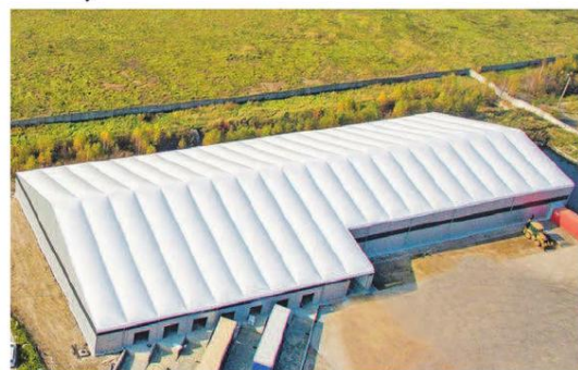
► FUNKCJONALNE I TRWAŁE: Hale namiotowe z pompowanym dachem, stawiane przez Pol-Plan, powstają w kilka dni, a dzięki modułowej konstrukcji dają możliwość szybkiej rozbudowy. [FOT.ARC]
