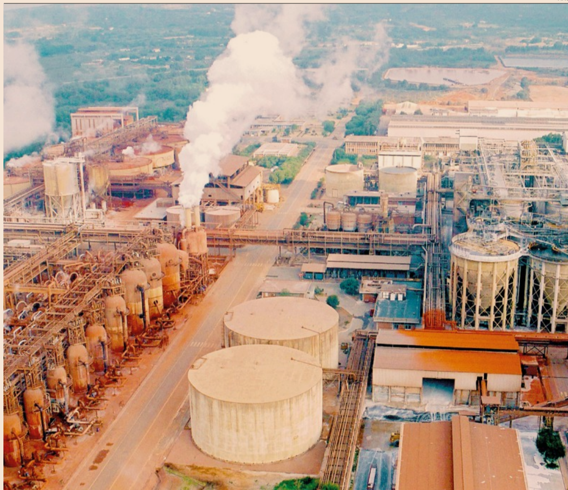
Uno dei più grandi d'Europa. L'impianto di Eurallumina a Portovesme è fermo dal 2009. La riapertura vale 1.500 posti di lavoro
