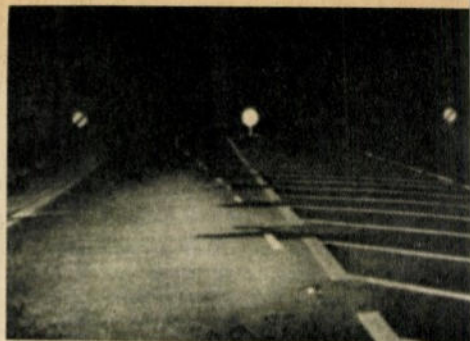
Útburkolat elől elzárt terület szembetűnővé tételére (forgalmi csomópontok, becsatlakozások előtt) is kitűnően felhasználható ez a jelzés
