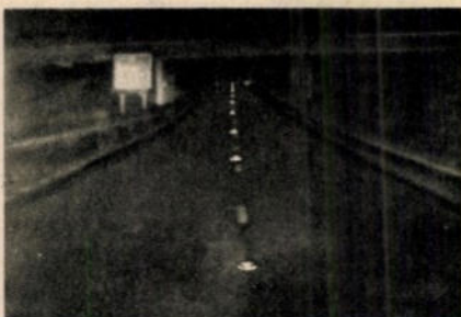
A sötétbe vesző út vonalvezetése a macskaszemekkel láthatóvá válik...
