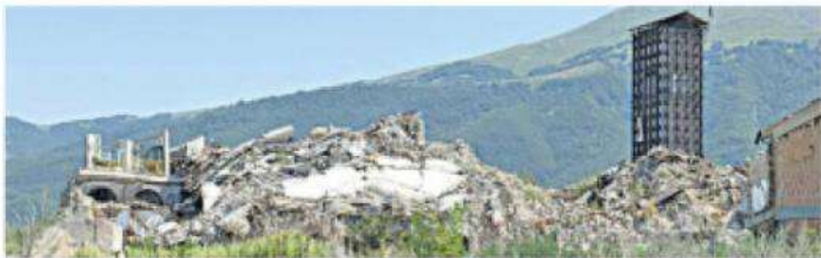
Amatrice. La ricostruzione nel paese colpito dal terremoto il 24 agosto 2016
