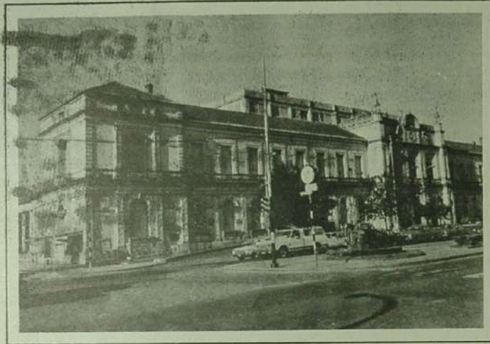
Edificio del Rectorado de la Universidad Nacional del Litoral en bulvar Pellegrini.
