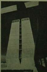
Aspecto de la torre de ventilación.
