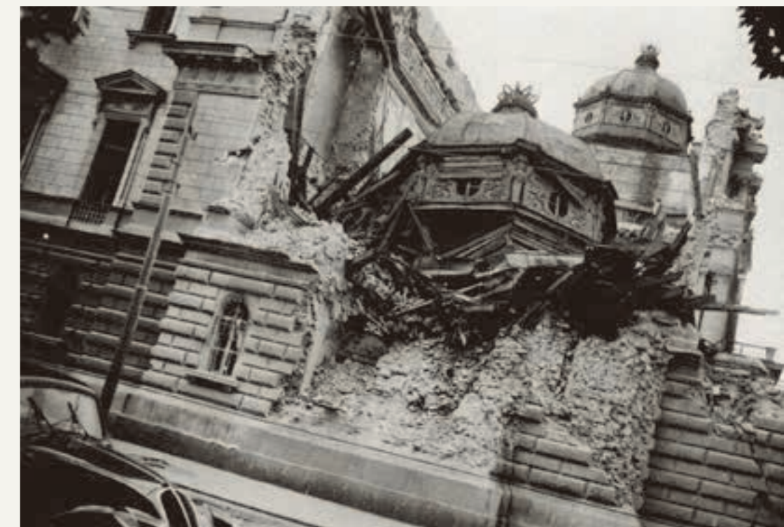
Поглед на тешка оштећења на Старом двору (Петар Боснић) Heavy damage at the Old Palace (Petar Bosnić)
