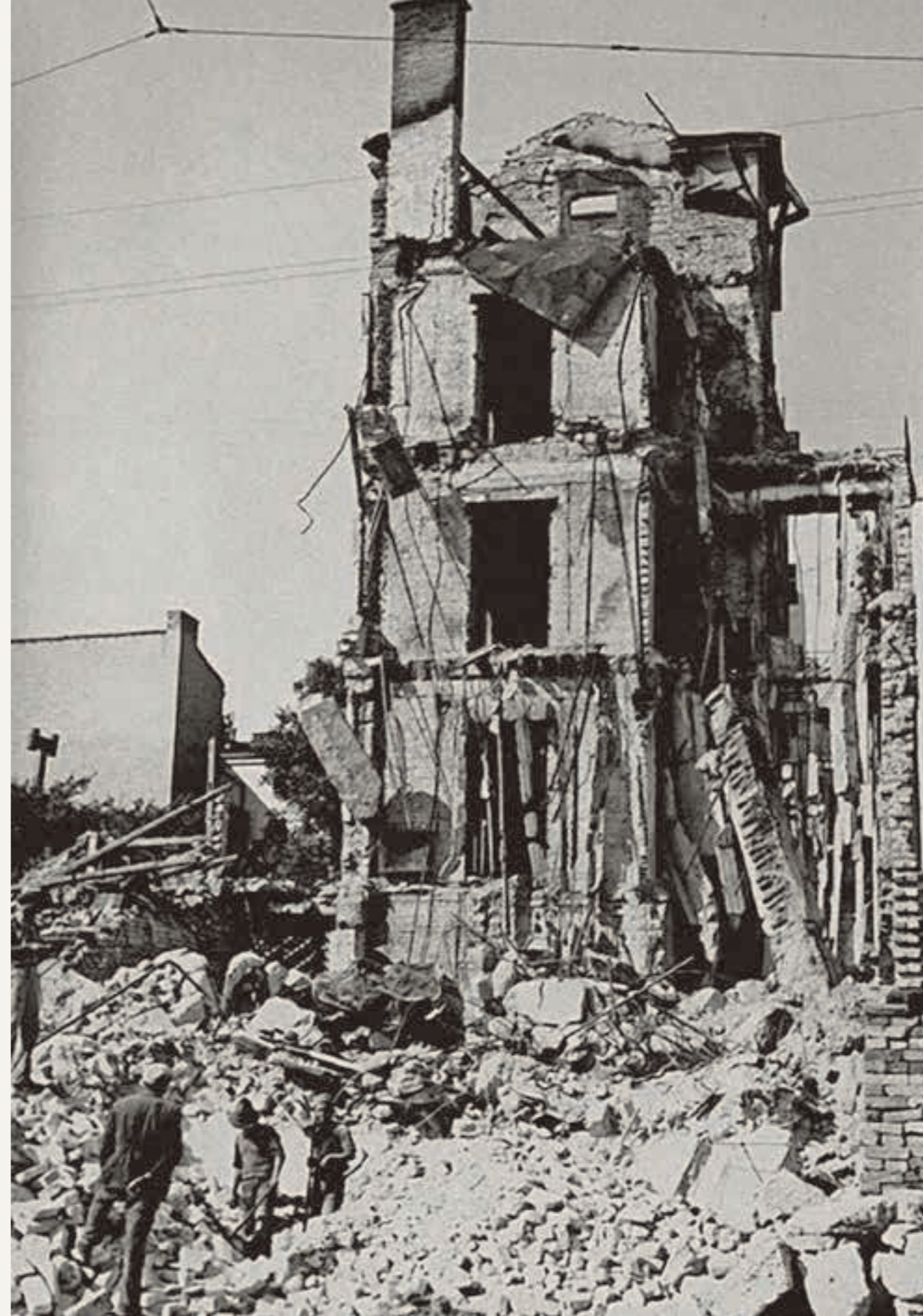
Тешко разрушена стамбена зграда, могуће у околини Славије (НБ) Heavily damaged residential building, possible in the vicinity of Slavija (NB)
