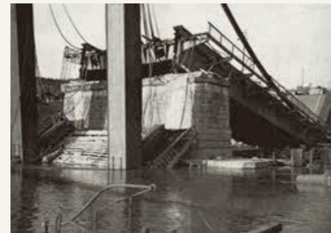
Потпуно разрушена конструкција Моста краља Александра (Curzio Malaparte) Completely destroyed construction of the Kralj Aleksandar bridge (Curzio Malaparte)
