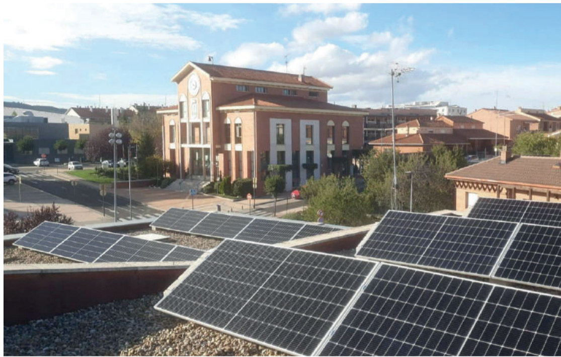
El Hogar del Jubilado ya cuenta con placas fotovoltaicas para disminuir la factura de la luz y evitar emisiones de CO 2 . ENA
