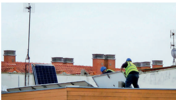
Los operarios instalan las placas solares en el tejado. ENA
